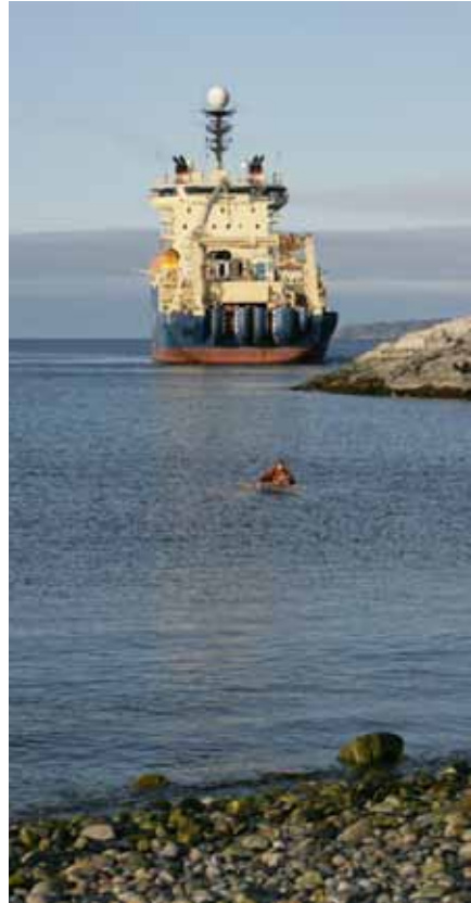
Kabelskeppet Ile de Sein vid framkomsten till Nuuk. När atlantkabeln ska dras i land får man hjälp av en kajakpaddlare som drar en lina från skeppet till stranden. Foto: Alcatel-Lucent.
